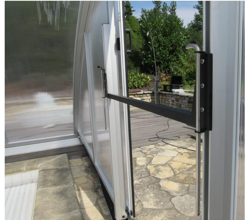
Tür in der Stirnwand mit Schiebetürschwelle, Die Schwelle ist nach oben und unten verschiebbar. und dient zur Stabilisierung der Überdachung. ab einer Breite von 6m wird von Werk aus eine Schiebetürschwelle verbaut.
